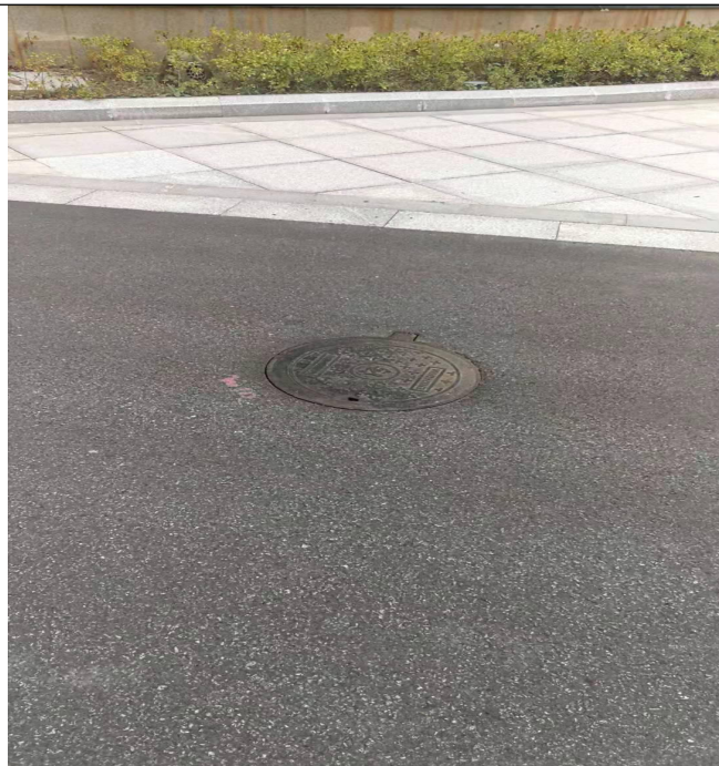
生活污水排放口
